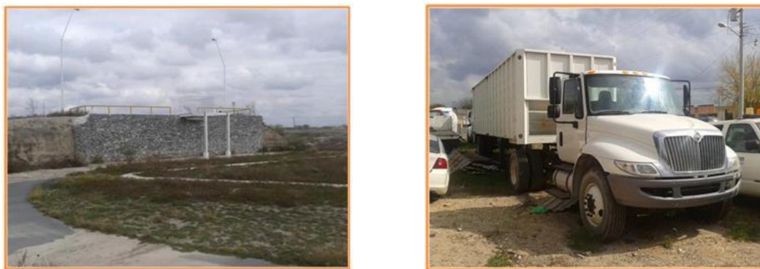
Figura 5. Estación de Transferencia y tracto camión en el municipio de Gustavo Díaz Ordaz.
