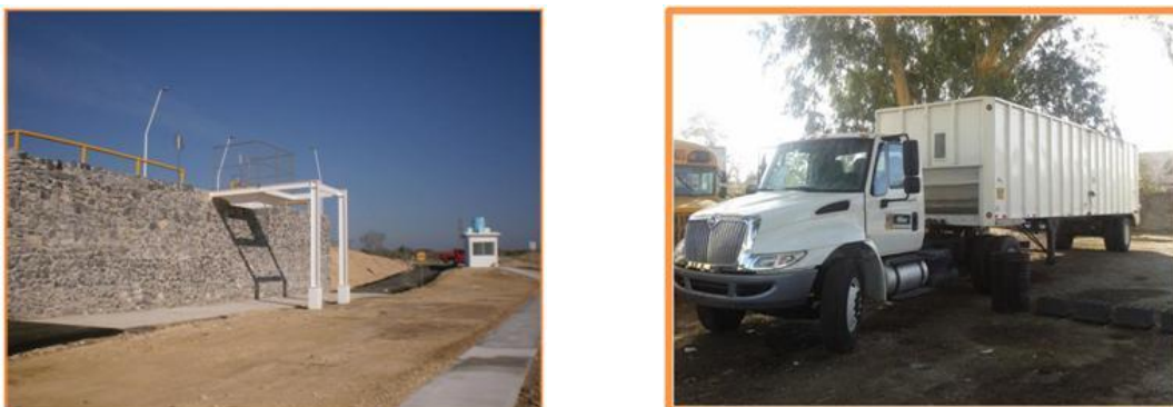
Figura 6. Estación de Transferencia y tracto camión en el municipio de Mier.
